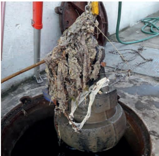
Leider gibt es mittlerweile regelmäßige Verstopfungen der Pumpwerke. In der Rudolf-Eisler-Gasse ist die Pumpe komplett ausgefallen. Die Reparaturkosten liegen bei über EUR 3000,- ! Die Verursachung liegt bei knapp 90 Prozent an der unsachgemäßen Entsorgung von Feuchttüchern im WC.
