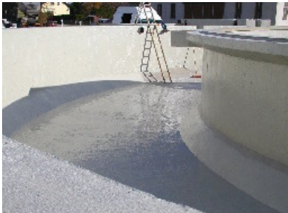
Saniertes Belebungsbecken nach Beschichtung 10/2004
