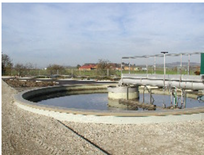
Saniertes Nachklärbecken 11/2004
